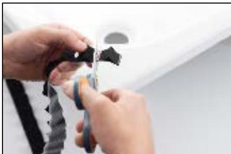
1. Die Wannenausgleichsecken mit einer Schere einzeln abschneiden.
