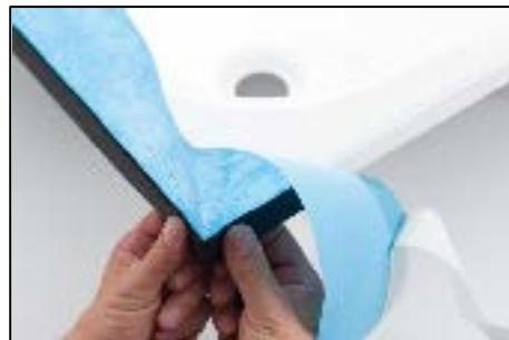
5. Im Bereich der Wannenausgleichsecke Nachdrücken, so dass ein dichter Verbund entsteht.
