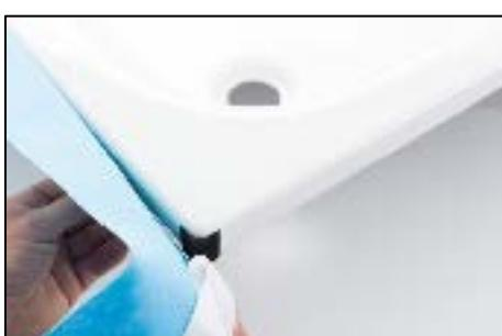
4. Anschließend das Wannendichtband an den Wannenrand und über die Wannenausgleichsecken fehlstellenfrei ankleben.
